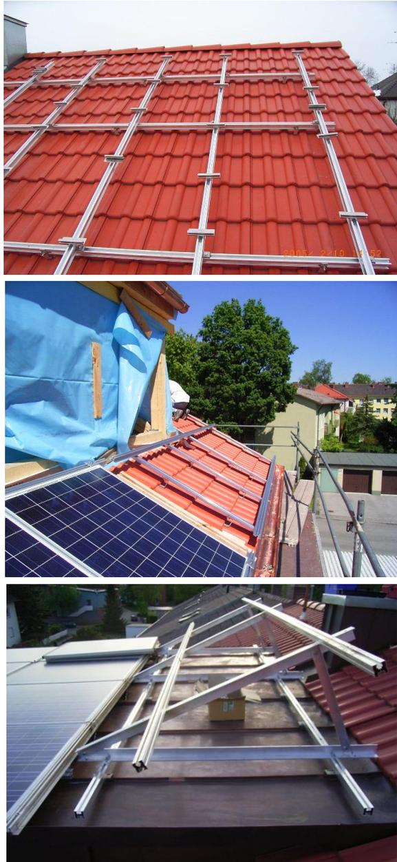
Abbildung 7-6 Unterkonstruktionen
